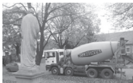
Služby města přiložily ruku k dílu v rámci oprav místní fary, vybetonovaly podlahy.
